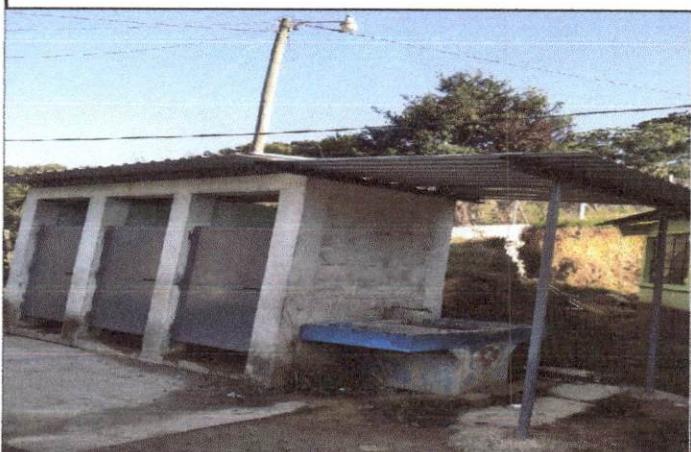
Finalización de techo de baño
