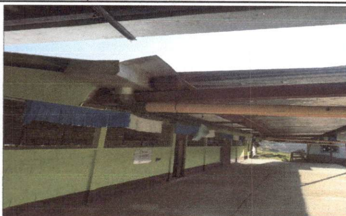
Finalización de canales
