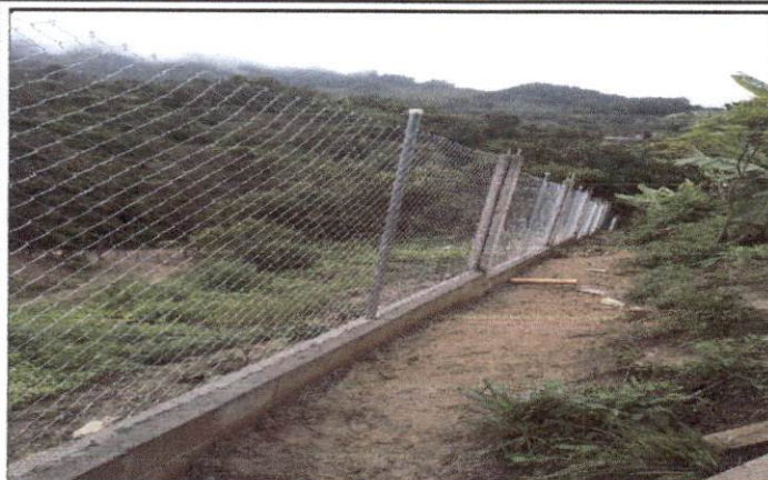
Finalización de muro perimetral
