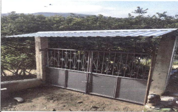
Finalización de portón
